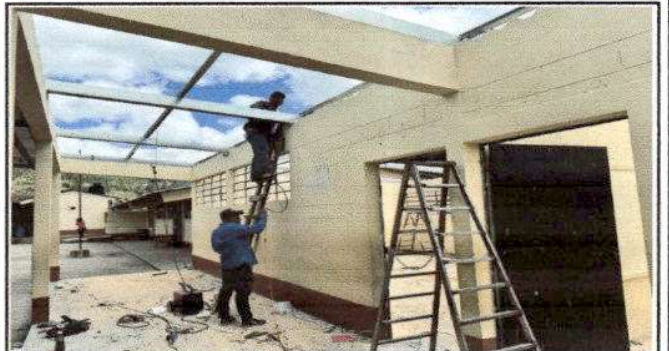
Foto 4: Sustitución de teja de concreto por estructura de metal
