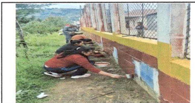
Foto 5: Pintura en muros exteriores e interiores
