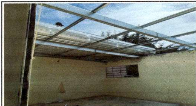
Foto 3: Sustitución de teja de concreto por estructura de metal
