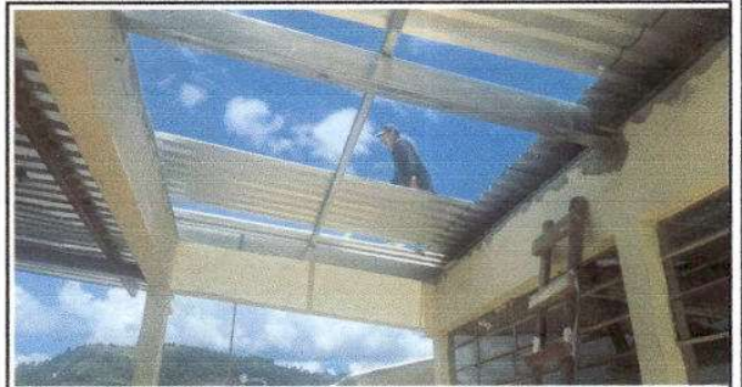
Foto 2: Sustitución de lámina, por lámina troquelada 13 pies
