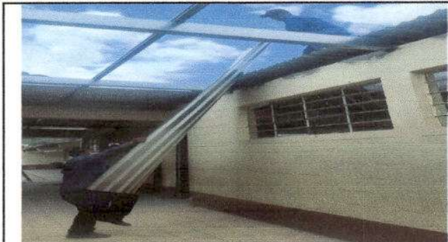
Foto 1: Sustitución de lámina, por lámina troquelada 23 pies
